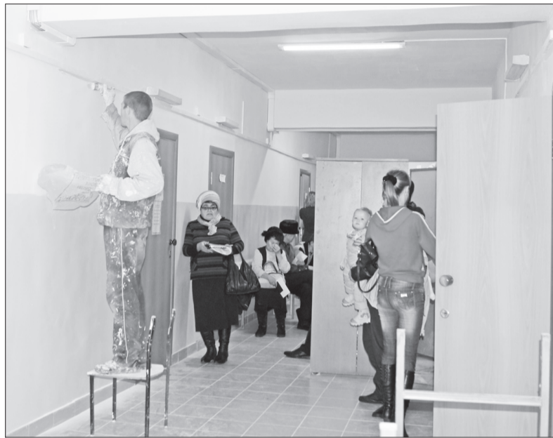
Поликлиника во время ремонта не прекращала своей работы...
