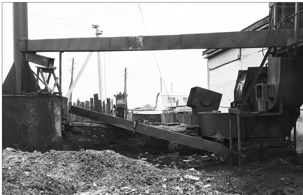
Разобранный дымосос, кучи шлака вместо угля – так выглядела котельная в Творогово в середине сентября...
