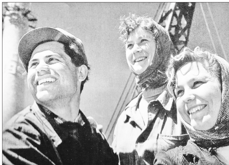
Первые строители завода. (Фото из книги «Тимлюйский цементный завод: страницы истории»).
